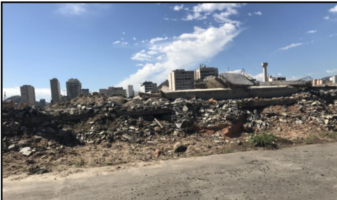
Figura 28 – Obras de execução do parcelamento do lote 239 A (2023)
