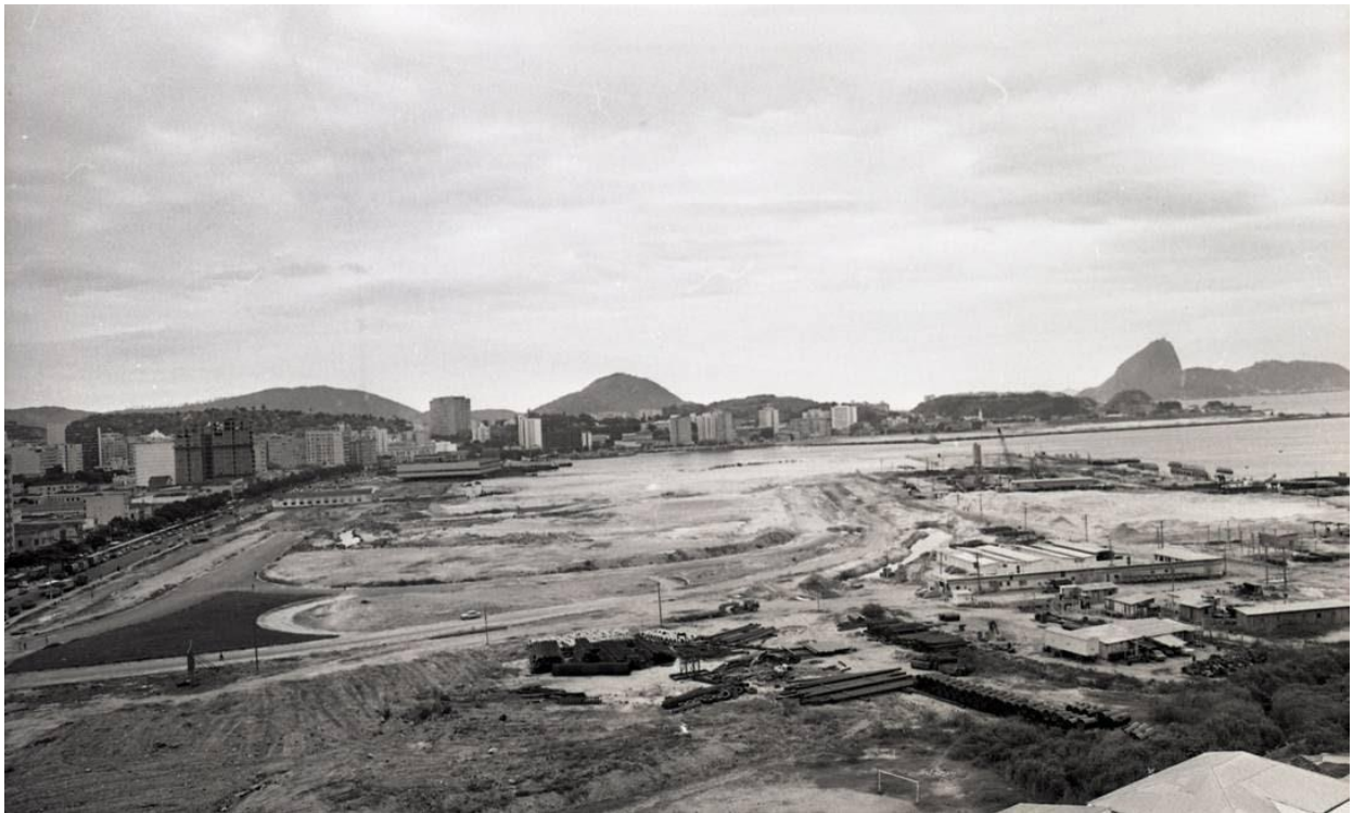
Figura 1 – Obras do aterro da Praia Grande - década de 70
