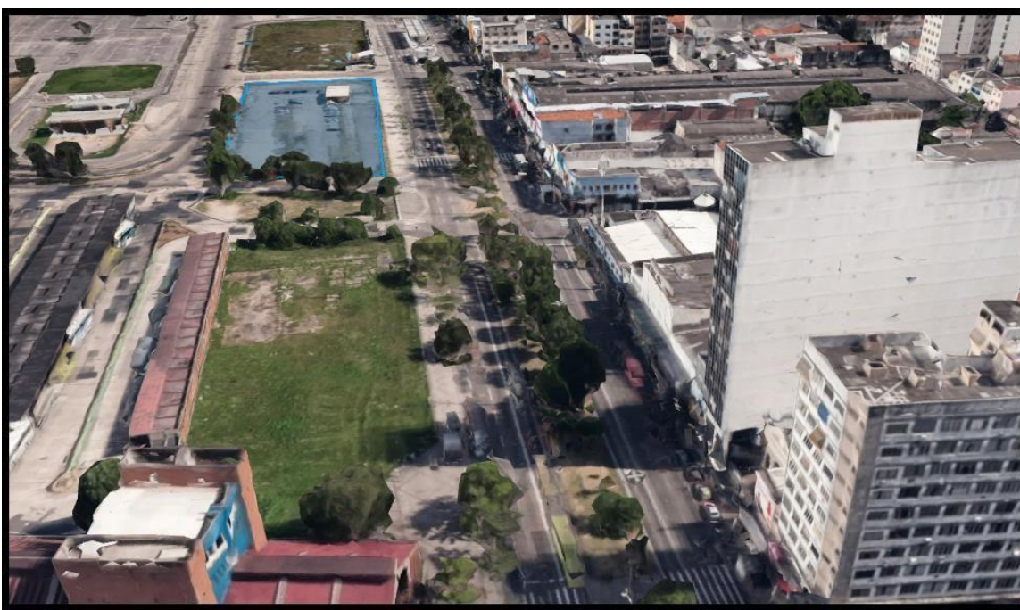
Figura 35 – Alinhamento das edificações (2021)
