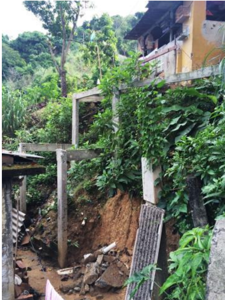
Figura 4.3.9 - Deslizamento do barranco no fundo da casa, situada abaixo de outra casa, promovendo efeito “dominó” na encosta e colocando as duas construções em risco
