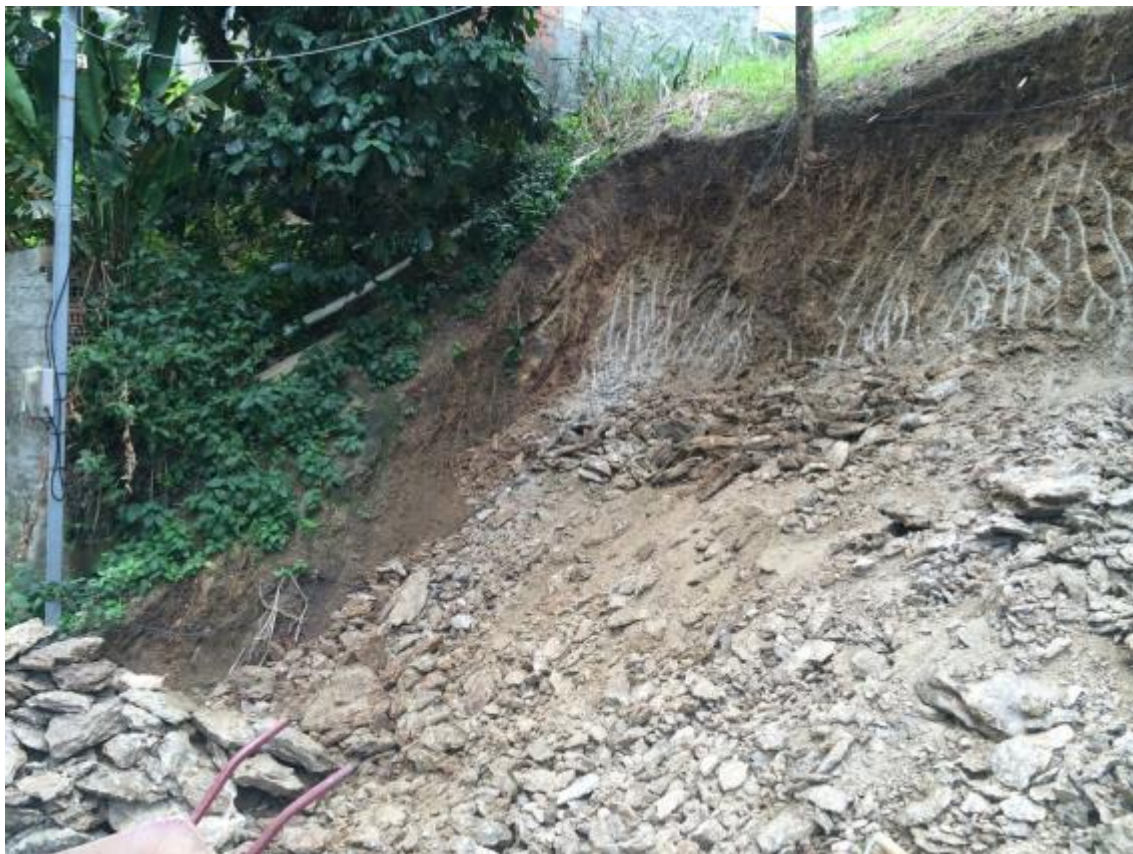
Figura 4.3.8 - Corte para construção evidenciando o perfil de solo até a rocha alterada. Ressalta-se a declividade da encosta na porção esquerda da foto
