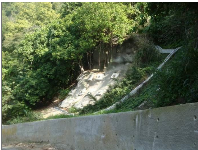
Figura 3-6 - Obras de contenção na estrada de Itaipuaçu, próximo ao mirante
