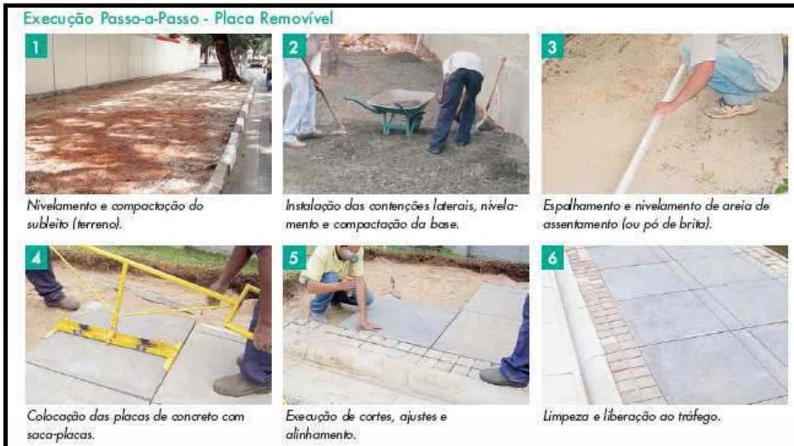
**Figura 32: Execução de pavimento em placas de concreto.**
