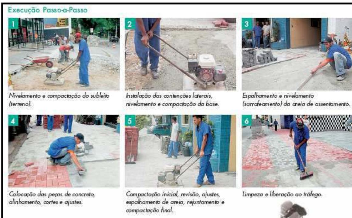
**Figura 31: Execução de pavimento intertravado**
